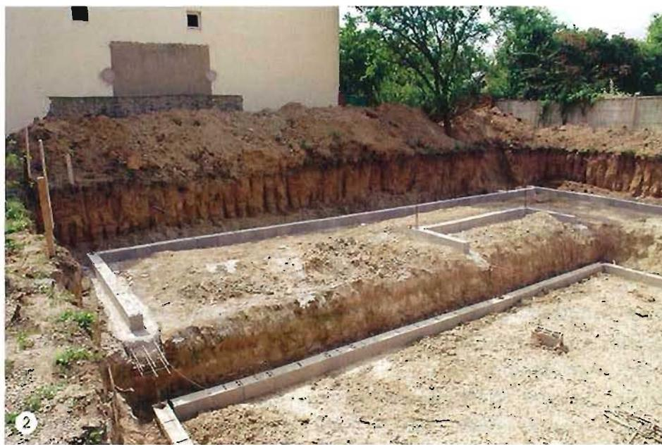
semelle est alors réalisée en béton ou en béton armé et c'est sur elle que repose tout le poids de la maison.
